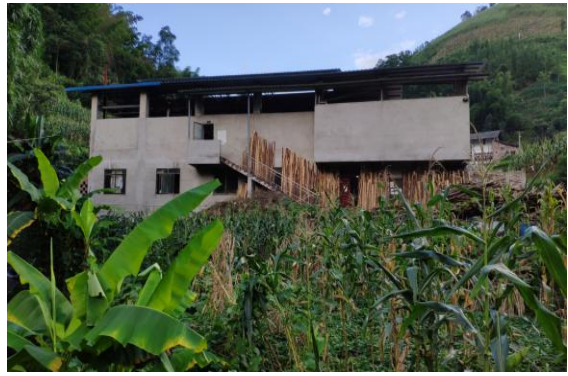
照片 2：项目区现状
