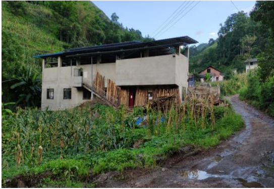
照片 1：项目区现状
